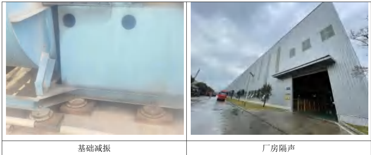
图 4.1-4 设施降噪措施照片
